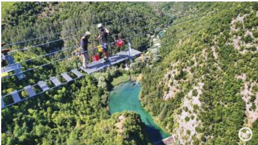
Figura 8 - Montaggio delle pedane
